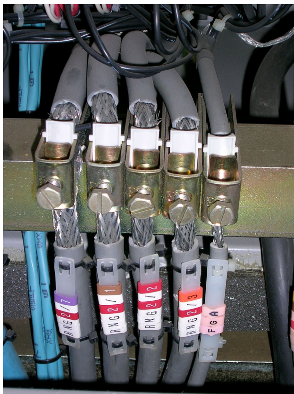
Figure 12 : Exemple 1 de liaison correcte de la tresse à la masse par cavalier métallique.
